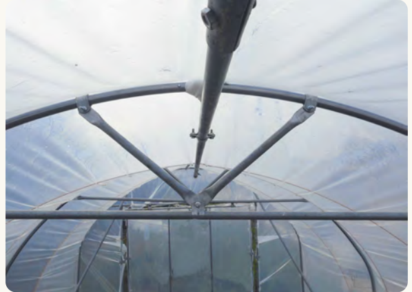
Detailansicht der Firststangen-Verbindung mit V-Verstreben im First.
